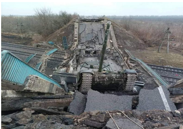
Ураження засобами РВіА шляхопроводу під час проходження по ньому колони ворожої техніки
